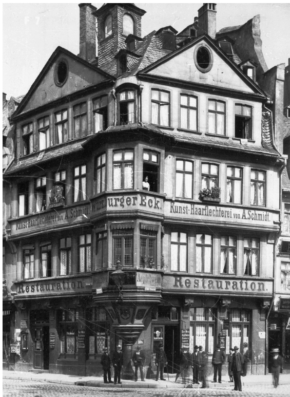
Bild 2. Wohn- und Gasthaus, Frankfurt (Main)
