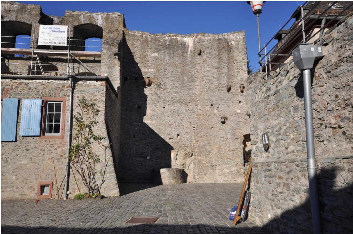
Abb. 10 Nordmauer Innenhof ohne Schießscharten
