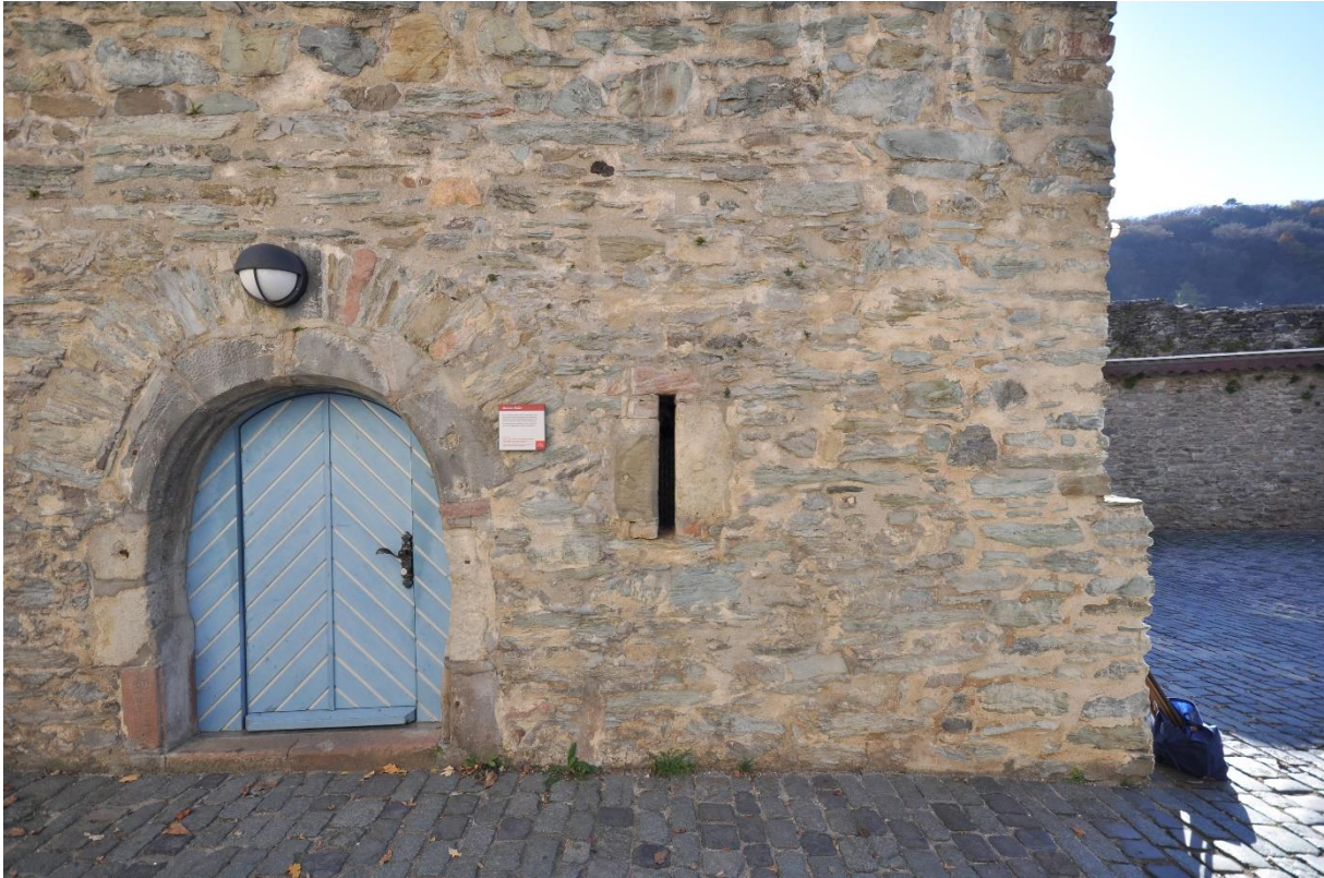
Abb. 11 Licht- und Lüftungsschlitze des Mainzer Kellers
