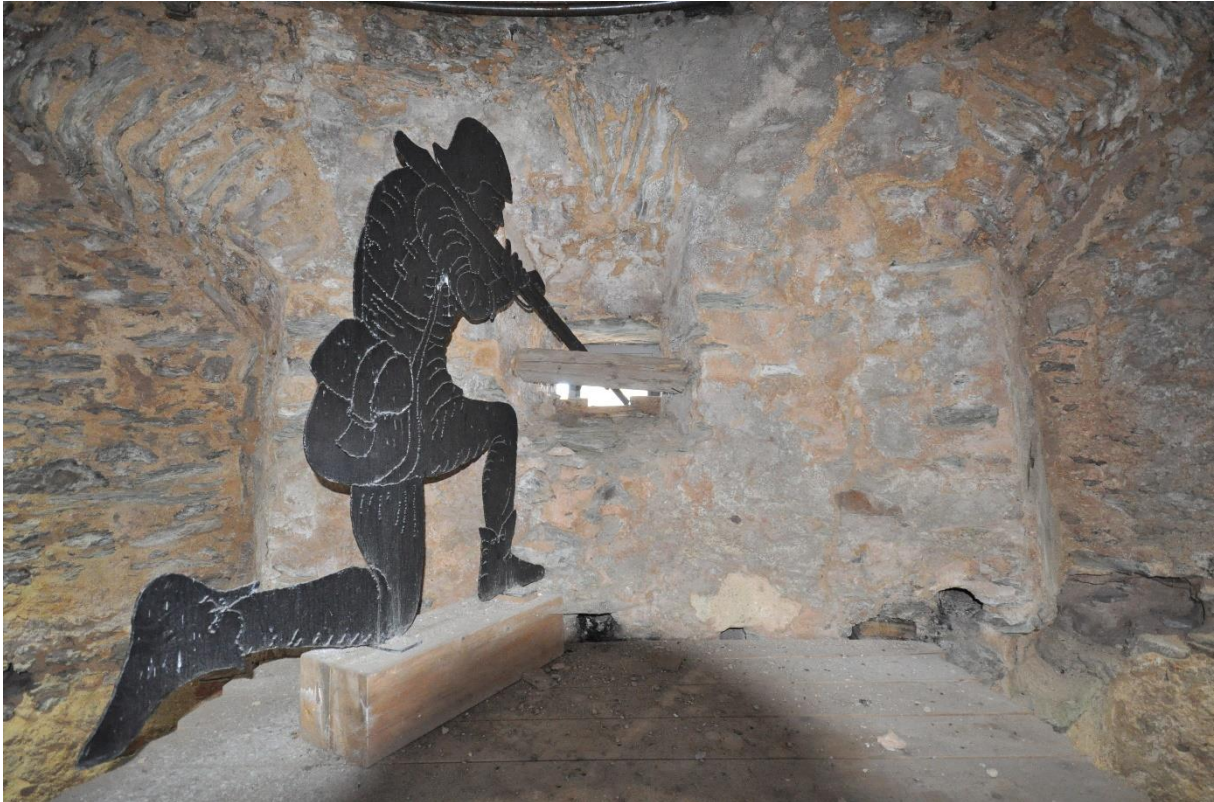
Abb. 13 Bergfried, Schießfenster mit Prellholz
