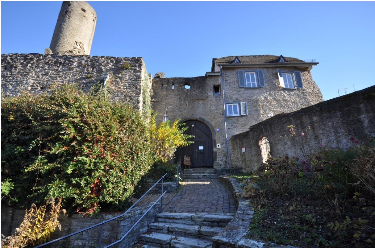
Abb. 6 Haupttor mit darüberliegendem Wehrgang
