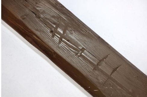
Abb.1: Abbundmarken mit Beizeichen. Wohnhaus, Karl-Lang Straße 2 in Bad Schwalbach.
