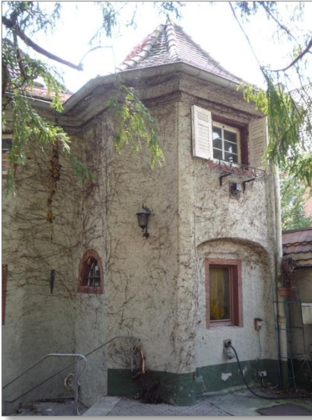
Bild 3: Auf der Fotografie sind die zugemauerten Öffnungen sowie das Pyramidendach des Kapellenanbaus, die hofseitig liegen, zu sehen.
