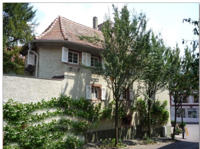
Bild 5: Die durchlaufende Wandfläche sowie die gleiche Traufhöhe führen die Südwest-Fassade des Adels-hauses in die Kapelle fort, wodurch sich diese miteinander verbinden. Das es sich um zwei Baukörper handelt ist erst bei genauerer Betrachtung an den unterschiedlichen Firsthöhen und dem Versatz im Sockel festzustellen.
